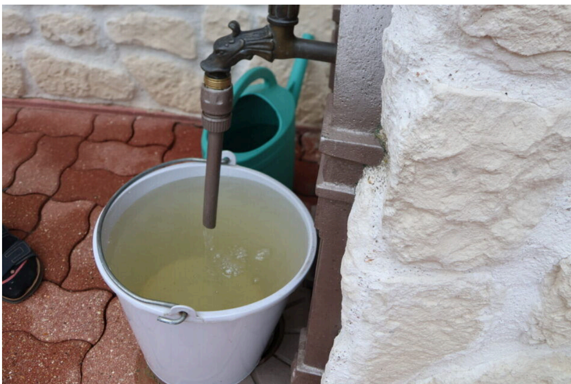
Une canalisation deau a cédé à Châteaubriant (Loire-Atlantique), rue Guy Môquet, entraînant une intervention rapide des équipes de Veolia. ©Illustration Nicolas Giorgi/Actu Oise
